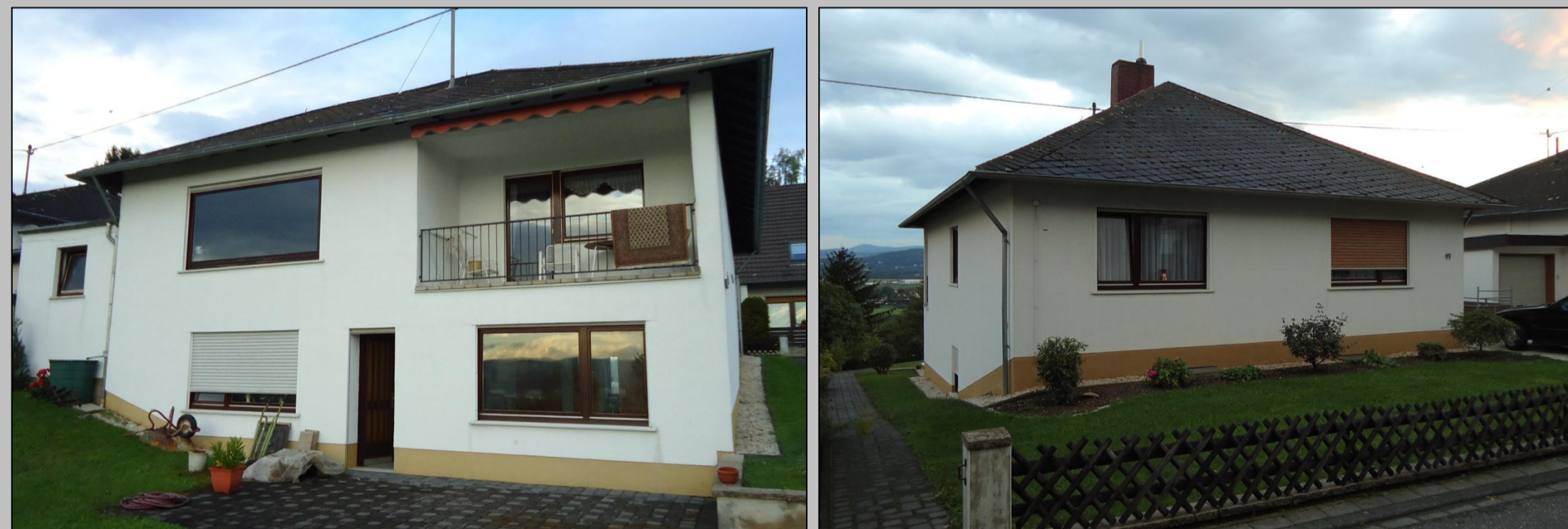
Das Referenzgebäude im Bestand
